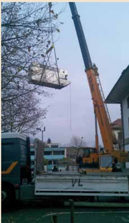
Der Einbau der neuen Anlage verlangte sorgfältige Planung
